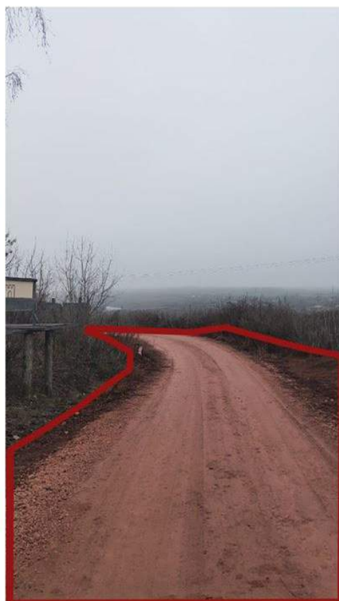
Отсутствие пешеходной связи
