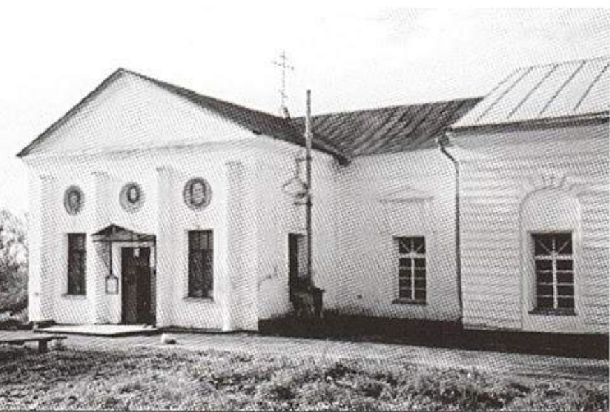
ФРАГМЕНТ СЕВЕРНОГО ФАСАДА.
