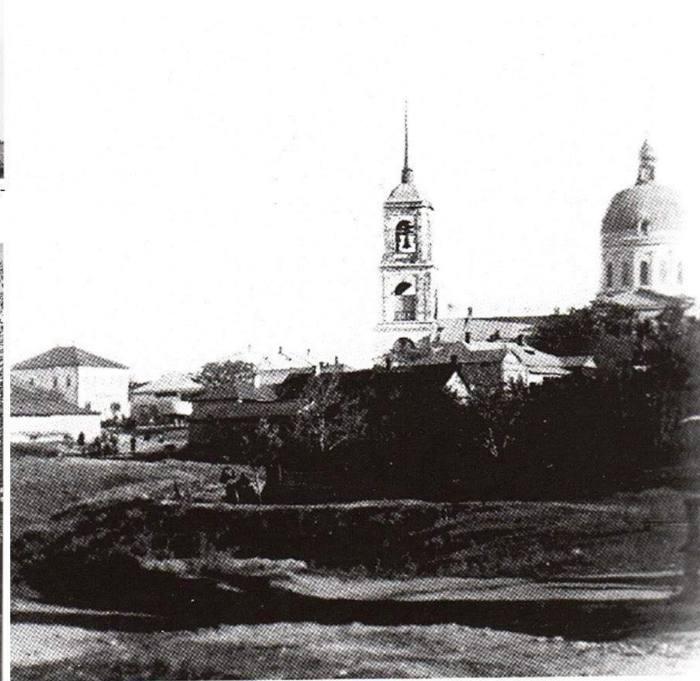
ВИД С НОВОСИЛЬСКОГО ГОРОДИЩА НА ИСТОРИЧЕСКИЙ ЦЕНТР ГОРОДА. СЛЕВА- НИКОЛЬСКАЯ ЦЕРКОВЬ. СПРАВА - УСПЕНСКИЙ СОБОР.
