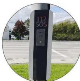
Модули вызова экстренной помощи размещаются по всей территории разрабатываемой территории на мачтах освещения, предназначены для вызова полиции, скорой, пожарных. Выполняет функцию безопасности на территории.
